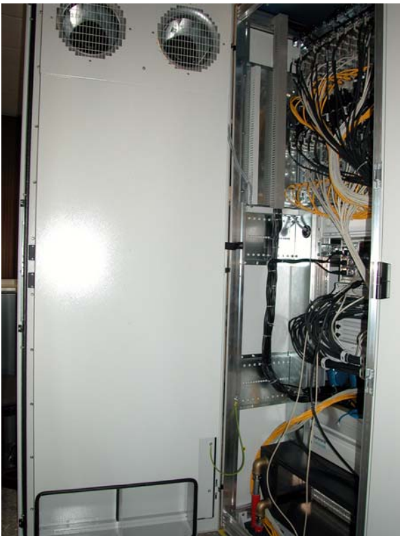
Abb. 2: Miracel CoolTerm mit geöffneter Rückwand
